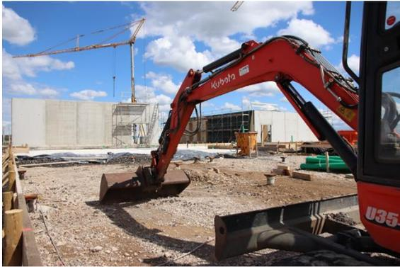
Noch dieses Jahr soll der Neubau bezugsfertig sein – obwohl der Start im Oktober vergangenen Jahres auf der gut 7000 Quadratmeter großen Fläche holprig verlief. Wegen unerwartet schwieriger Untergrundverhältnisse mussten zunächst rund 300 duktile Pfähle in den Boden gerammt werden. Und noch eine beeindruckende Zahl: In der Bodenplatte werden etwa 120 Tonnen Stahl eingearbeitet.
